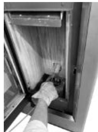
**Fig. 36 - Nettoyage avec nettoie-pipes**
