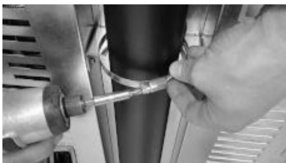
Fig. 72 - Bloquer avec un collier de serrage
