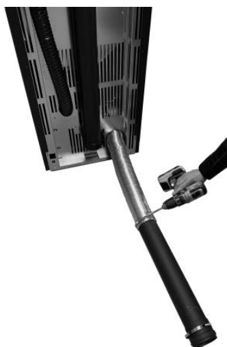
Fig. 81 - Raccorder le tuyau d.80 mm
