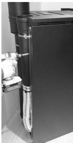
Fig. 30 - Retirer les vis.
