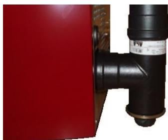
Fig. 30 - Nettoyage du conduit de fumée
