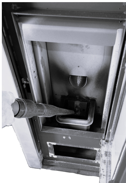
Fig. 39 - Nettoyage l'espace du brasero
