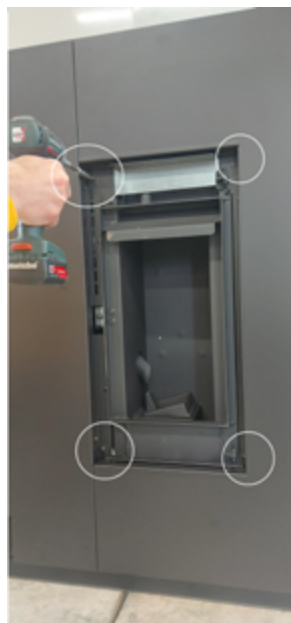
Fig. 66 - Démontage 2
