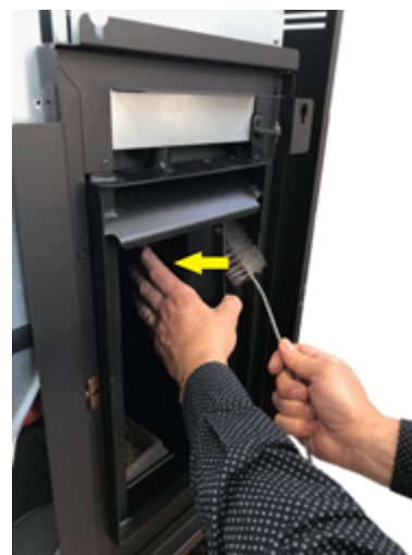
Fig. 101 - Nettoyer avec un goupillon
