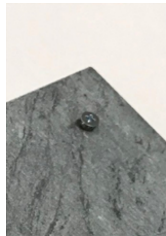
Fig. 46 - La vis doit dépasser
