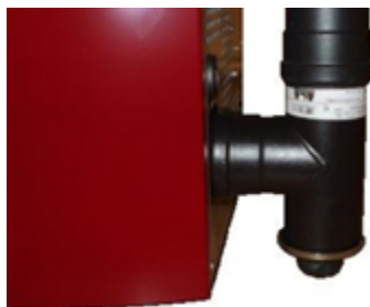
Fig. 96 - Nettoyage du conduit de fumée
