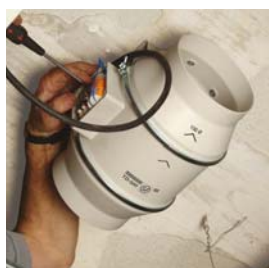
Réaliser les connections.
