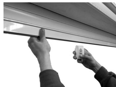
6. Faites monter et descendre le volet complètement et vérifiez que le moteur s'arrête de façon à ce que la lame finale reste engagée dans les coulisses (dans le cas de la montée) et que le moteur s'arrête juste après que tous les ajours du volet soient tassés.
