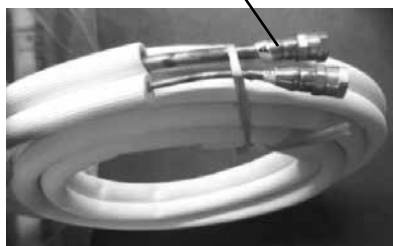
Conduite de frigorigène Raccords (deux extrémités)
