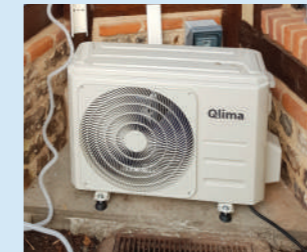
pose sur dalle béton avec pieds anti vibration
