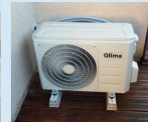
pose sur support PVC
