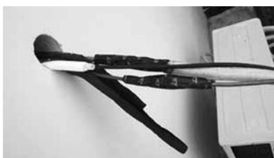
9. Puis enveloppez les raccords du matériau d'isolation noir, pour la partie exposée supérieure, utilisez le matériau d'isolation blanc (fourni dans la boîte d'accessoires) pour l'envelopper complètement.
