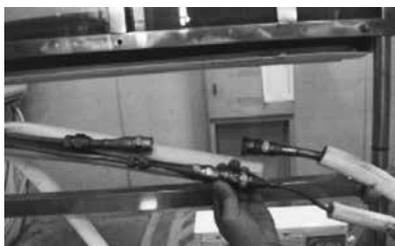
3. Maintenez les points marqués en utilisant une clé plate et ne tournez les écrous qu'aux points marqués à l'aide d'une clé plate (sélectionnez la bonne clé selon les dimensions du raccord).
