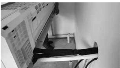
**REMARQUE** : Les pièces du raccord rapide doivent être placées à l'extérieur de la salle. Utilisez le manchon à trou mural, le capuchon et le néoprène pour sceller le trou mural.
