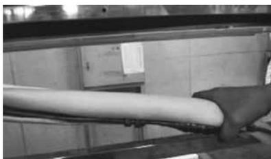
6. À la fin du raccordement, le couple des raccords rapides fait passer le tuyau de vidange et les conduites de frigorigène à travers le trou mural comme indiqué dans la Fig.4.10.
