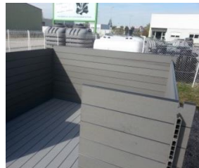
montage par emboîtement
