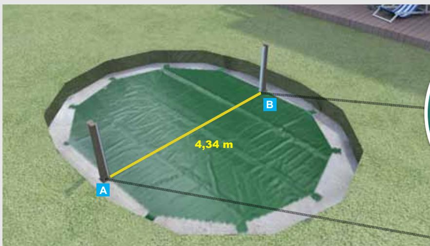
Répéter l'opération pour le deuxième poteau et vérifier la distance (4,34 m) entre les poteaux A et B.
