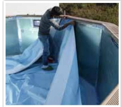
Insérez horizontalement la lèvre du Liner dans le support d'accrochage en PVC. Le Liner restera accroché automatiquement dès qu'il sera sur la verticale.
