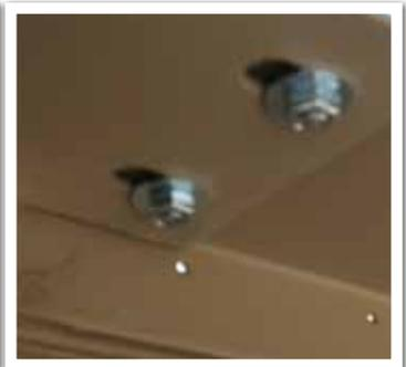
Les supports en acier sont fixés à l'aide de vis et écrous fournis dans le kit (utilisez les outils adaptés).
