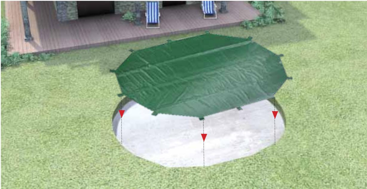
Positionner le gabarit sur la dalle béton en l'ajustant correctement au sol pour éliminer les plis.
