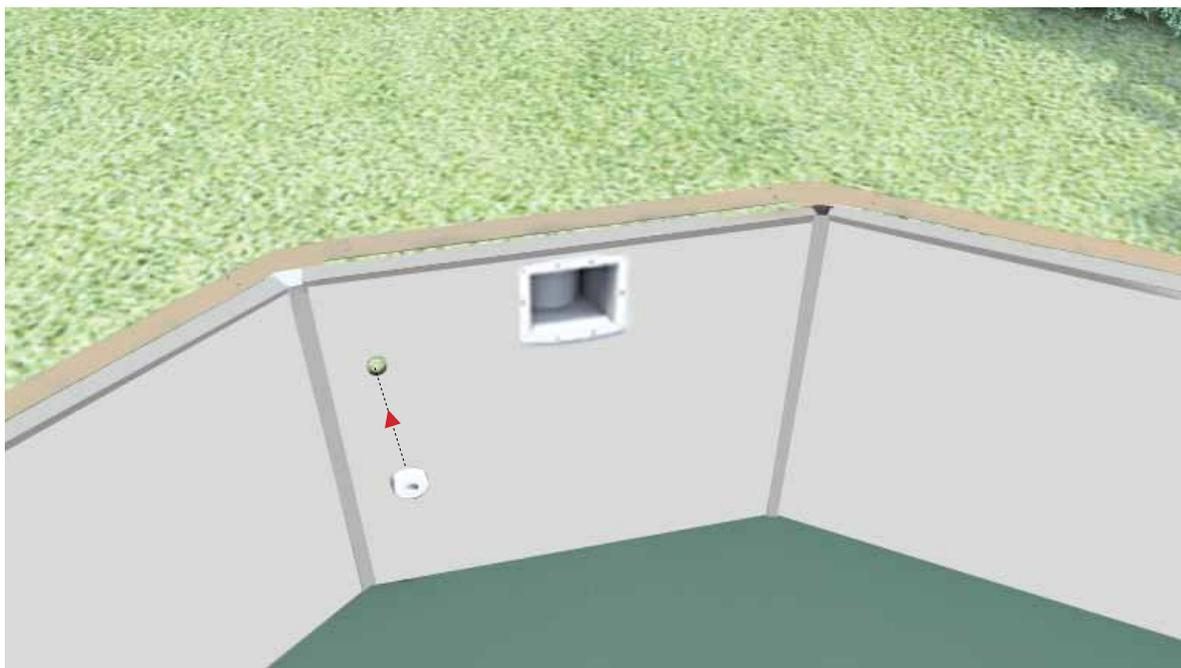
Le refoulement est placé sur la perforation existante conçue à cet effet.
