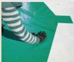
Une fois le premier poteau fixé et d'aplomb, il faut positionner le deuxième **poteau B** à l'autre extrémité en faisant attention que le gabarit soit bien positionné sur la dalle en béton.
