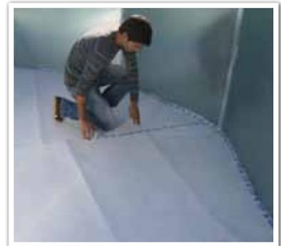
En suite positionnez bien à plat les différentes pièces sur le fond de la piscine, les unes contre les autres, sans les chevaucher et terminer avec l'application d'un ruban adhésif sur les unions des différents éléments.
