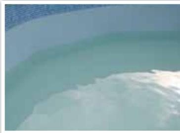
Vérifiez que le Liner se trouve correctement placé sans plis, si des petits plis persistent, vous devez l'aider à se placer correctement pendant le remplissage de la piscine jusqu'à la hauteur de 30 cm d'eau.
