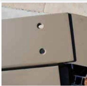
Vous devez positionner les supports des margelles sur la base haute des poteaux en ajustant les trous avant de visser (vérifier l'alignement).
