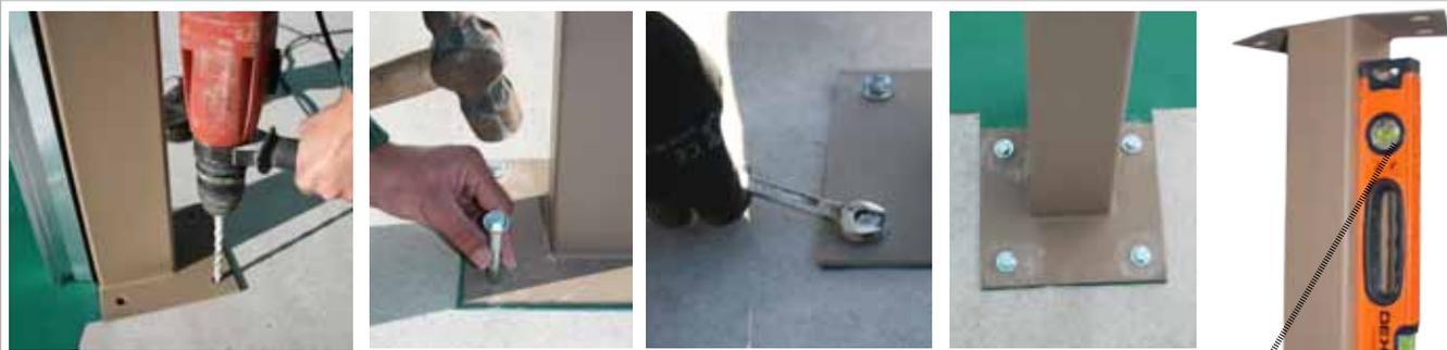
Après avoir positionné le premier poteau vous devez effectuer le perçage à l'aide d'une perceuse et le fixer immédiatement à la dalle en béton au moyen de vis et chevilles métalliques fournies dans le kit.
