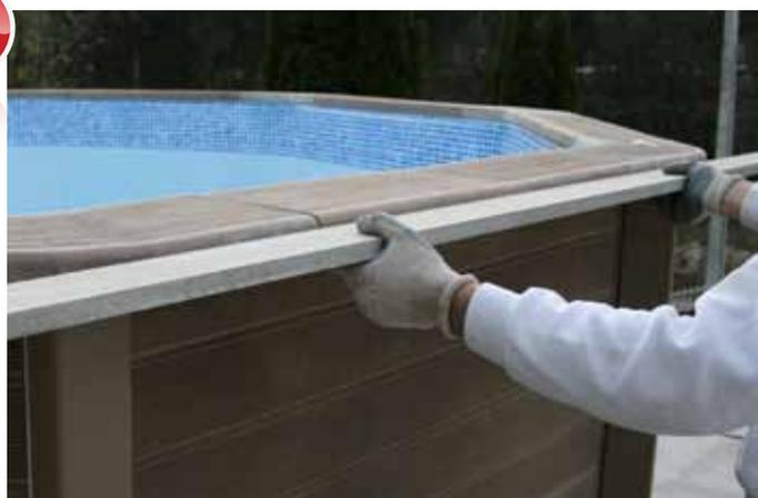
La fixation de la margelle est réalisée avec le silicone, fourni dans le kit. Au fur et à mesure de la fixation de la margelle, il est nécessaire de vérifier le niveau.
