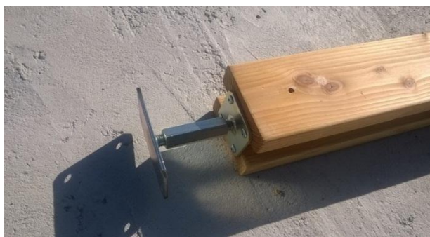
Fixations pied de poteau fixe avec 4 vis 8/80
