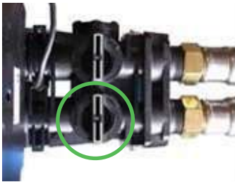
1. Ouvrir la vanne d'arrivée d'eau
