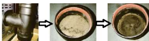
FIGURE 8 – Té de fumisterie avec trappe de visite
