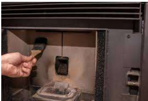
FIGURE 6 – Nettoyage chambre de combustion
