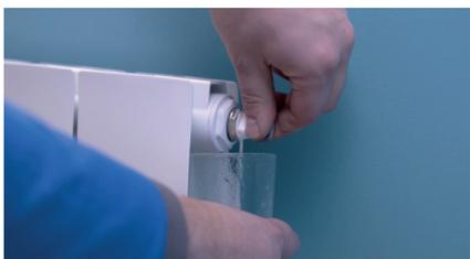
Chassez l'air du radiateur en ouvrant le robinet de purge. Lorsque l'air a été totalement évacué, refermez le robinet de purge.
