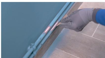
Pour simplifier la pose des nouveaux raccords de tube, ne coupez pas les tubes existants au même niveau mais en décalé.
