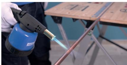
Réalisez le cintrage en commençant par recuire le cuivre à l'aide d'une lampe à souder sur 15 cm de part et d'autre de votre repère.
