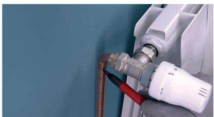
Coupez le tube et posez-le à blanc afin de vérifier qu'il est à la bonne dimension. Enfin, marquez les repères d'alignement et de profondeur du tube avec le raccord soudé.
