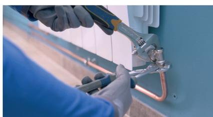
Enfin, raccordez le tube de retour en réalisant les opérations de brasage et de raccordements.
