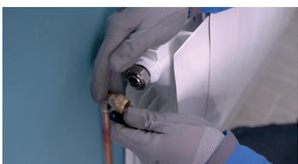
Afin de raccorder votre montage au corps thermostatique du radiateur, grattez d'abord le filetage du raccord fer-cuivre à l'aide d'une lame de scie à métaux.
