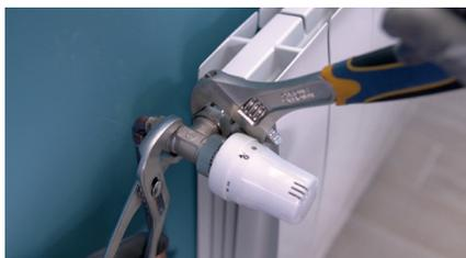
Alors que le radiateur se remplit, vérifiez l'étanchéité des raccords, s'ils présentent une fuite, resserrez les raccords.
