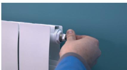
Avant de remplir le radiateur, vérifiez que le robinet de purge de votre radiateur est correctement fermé. Ouvrez ensuite la tête thermostatique en position maximum.
