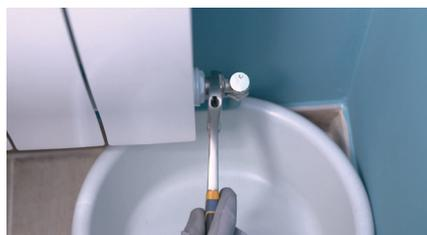
Vidangez le radiateur en desserrant doucement l'écrou du té de réglage situé en partie basse.
