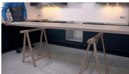
Posez le plan de travail à découper sur les tréteaux et fixez-le à l'aide de serre-joints.
