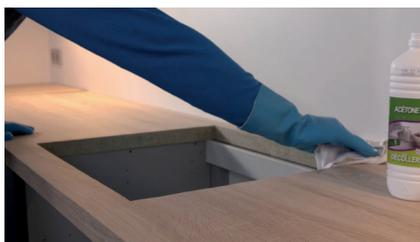
Afin que le joint se place parfaitement sur le plan de travail, dégraissez le tour de la découpe à l'acétone. Le joint isole et assure l'étanchéité entre le plan de travail et la plaque.
