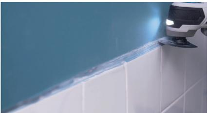
Utilisez un outil multifonction pour découper la zone sur laquelle est posé le carrelage. Puis ôtez les plaques de plâtre.
