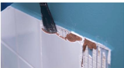
Cassez les carreaux suivant à l'aide du ciseau à brique en les attaquant par leur tranche. Continuez à ôter les carreaux un à un.
