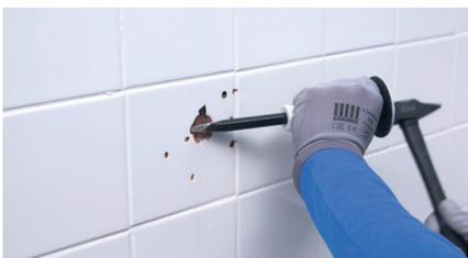
Si la zone à décarreler ne présente pas de zones accessibles, tapotez le mur plein à l'aide d'un burin pic pour repérer une zone qui sonne creux. Cassez le carreau avec le burin pic, puis le ciseau à brique.
