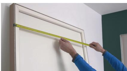
Pour préparer la pose de la porte, mesurez l'épaisseur, la largeur et la hauteur de l'ouverture.
