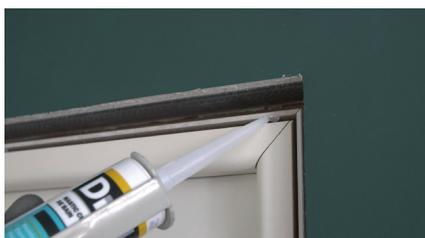
Dans notre cas, nous allons commencer par poser le chambranle horizontal. Pour cela, appliquez quelques points de silicone au fond de la feuillure du bloc porte.
