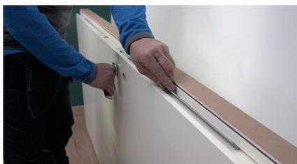
Pour faciliter l'installation de la porte, installez provisoirement la poignée de porte. Puis, coupez la cale en 2 parties égales. Entrouvrez la porte et glissez les 2 cales entre le dormant et l'ouvrant, de part et d'autre de la gâche. Refermez la porte.
