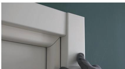
Insérez le chambranle vertical. Faites de même de l'autre côté du bloc porte.
