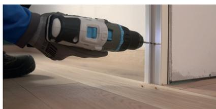
Pour ce faire, prépercez le bâti en utilisant une mèche à bois d'un diamètre égal aux vis de fixation.
