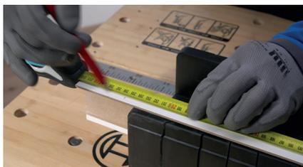
Pour poser les chambranles verticaux, mesurez tout d'abord la hauteur du bloc porte, chambranle horizontal compris.
