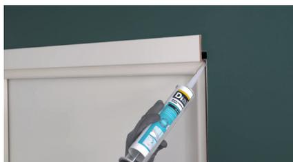
Pour fixer le chambranle vertical, appliquez quelques points de silicone au fond de la feuillure du bloc porte.
