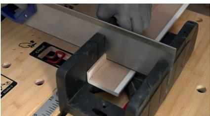
Tracez les traits de coupe. Coupez le chambranle vertical à l'aide d'une boîte à onglet et d'une scie à dos.
