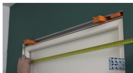
Vérifiez de nouveau l'équerrage en mesurant l'écartement entre les montants verticaux. La mesure doit être identique en bas et en haut de la porte.
