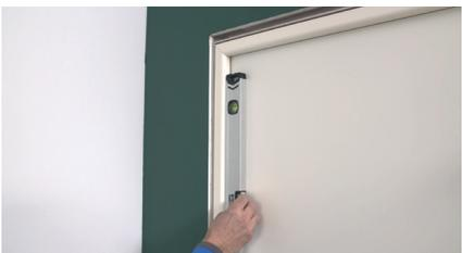
Puis vérifiez l'équerrage en plaçant le niveau à bulle à l'intérieur de chaque montant vertical.
