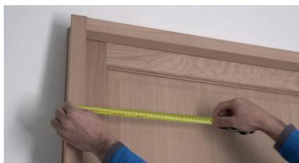
A l'aide d'un mètre, mesurez la hauteur, la largeur et l'épaisseur de l'ouverture, puis vérifiez qu'elles sont bien adaptées à celles du bloc porte.
