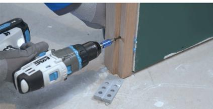
Fixez le bâti dans le mur à l'aide de vis adaptées à la nature du mur. Maintenez bien les cales en place lors du vissage.
