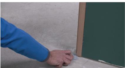
Nous ajustons la position du bâti à l'aide d'une cale.
