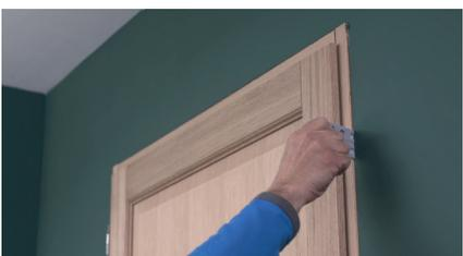
Insérez des cales en bas de la porte et sur le côté, entre les murs et le bâti, afin de maintenir le bloc porte en position.
