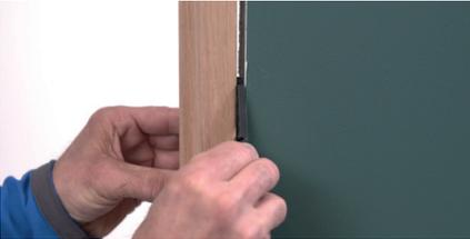
Une fois les réglages effectués, ajoutez des cales en plusieurs endroits pour combler l'espace entre le mur et le bâti afin qu'il ne bouge pas pendant que vous le fixerez.
