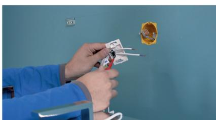
Vissez les spots sur l'armoire, puis posez-la sur le plan vasque afin de réaliser le raccordement électrique.
