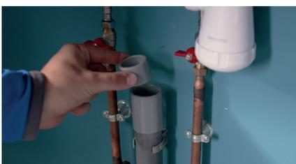
Prenez un manchon et poncez l'intérieur de ses extrémités. Appliquez-y de la colle PVC puis glissez-le sur le tube. Poncez la réduction, à l'intérieur et à l'extérieur. Encollez le manchon puis insérez la réduction à l'intérieur, butées vers le bas.
