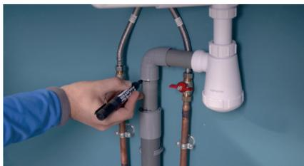
Ensuite, réalisez le montage à blanc afin de repérer l'alignement du coude et la profondeur à laquelle l'enfoncer dans les tubes.
