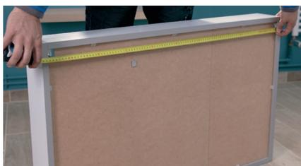
Sur l'armoire, mesurez la distance entre les deux points de fixations. Divisez cette mesure par deux, et reportez la dimension obtenue de part et d'autre du point médian tracé sur le mur.
