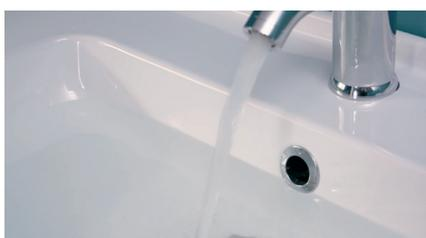
Pour vérifier l'étanchéité de l'évacuation, fermez la bonde et remplissez la vasque d'eau froide jusqu'au trop-plein. Vérifiez l'étanchéité du trop-plein et resserrez les bagues si nécessaire.
