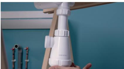
Raccordez le trop-plein au conduit d'évacuation de la bonde. Vissez le siphon sur la bonde, sans serrer.
