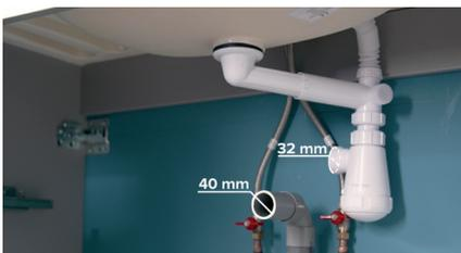
Dans notre cas, le tuyau d'évacuation a un diamètre de 40 mm, et la sortie du siphon un diamètre de 32. Pour raccorder le siphon à l'évacuation, nous devons poser une réduction.
