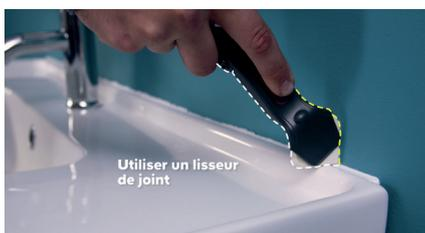
Enfin, réalisez un joint silicone entre le mur et le plan vasque.
