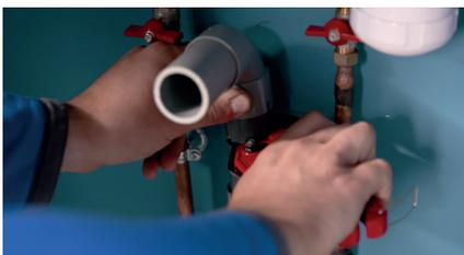
Commencez par couper le tuyau d'évacuation en-dessous du coude, à l'aide d'une pince coupe-tube PVC. Puis poncez l'extrémité du tube.
