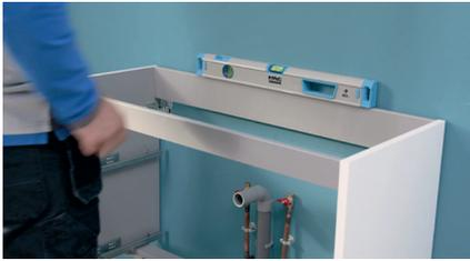
A l'aide d'un niveau, vérifiez que la surface du meuble est bien plane. Au besoin, ajustez les pattes de fixation. Une fois le meuble en place, vissez les fixations murales.
