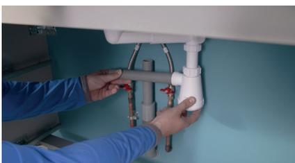
Posez un tube PVC sur la réduction, de façon à atteindre, voire dépasser, la sortie du siphon. De la même manière, placez un autre tube PVC dans la sortie du siphon.
