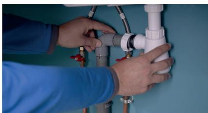
Placez la bague puis le joint conique du siphon sur le tube horizontal. Vissez la bague au siphon.
