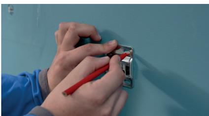
A l'aide d'un détecteur de métaux, vérifiez l'absence d'obstacle dans le mur. Ajustez vos repères si nécessaire. Positionnez une patte de fixation murale à chaque extrémité de votre mesure sur le mur, et marquez les points de perçage.
