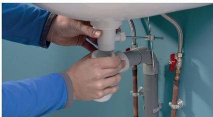
Placez une bassine sous le siphon, puis dévissez-le et retirez-le. Si les arrivées d'eau sous le lavabo disposent de vannes d'arrêt, fermez-les. Ensuite, dévissez les flexibles à l'aide d'une clé à molette et d'une pince multiprise.
