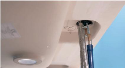
Installez les bagues de maintien sur les tiges filetées. Glissez d'abord celle en caoutchouc puis celle en métal.
