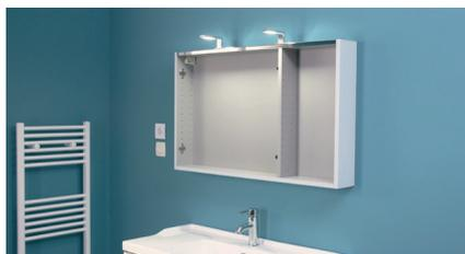
Posez ensuite l'armoire sur les pattes de fixation. Vérifiez la planéité de l'armoire à l'aide d'un niveau. Au besoin, ajustez les fixations. Ensuite, vissez les fixations murales.
