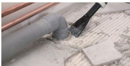
Dans les angles et aux abords d'obstacles tels que des tuyaux, finissez la dépose, avec précaution, au marteau et au ciseau à brique.
