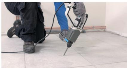
Commencez par percer au perforateur muni d'un burin pic. Inclinez-le pour fragiliser et casser le carrelage.
