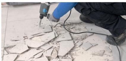
Dès que l'espace dégagé est assez large, utilisez le burin plat 20mm et continuez la dépose. Pour une meilleure visibilité de l'avancement de la dépose, nettoyez régulièrement la zone de travail.
