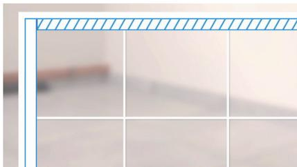
Pour savoir à quel endroit commencer la dépose de plinthes, repérez dans un angle celles qui reposent sur les autres. Puis à l'aide d'un marteau et d'un ciseau à brique, débutez la dépose à la jonction entre deux plinthes.
