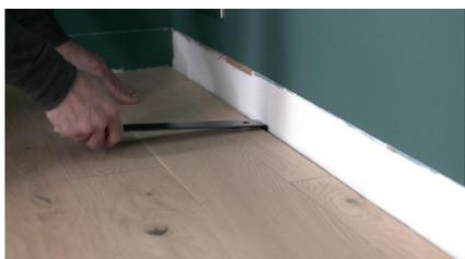
Glissez le tire-lame dans le joint de dilatation, entre une lame en longueur et le mur.
