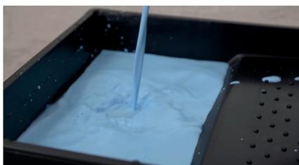
Avant de réaliser le ragréage, appliquez un primaire d'accrochage. Il va réguler la porosité de la surface, faciliter le lissage du ragréage et éviter que des bulles n'apparaissent en surface. Versez le primaire d'accrochage dans un bac à peindre.
