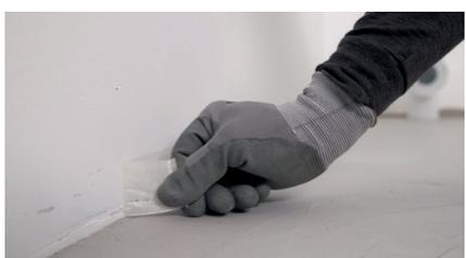
Une fois le sol totalement recouvert, laissez sécher le ragréage le temps indiqué par le fabricant. Retirez l'adhésif de masquage à l'aide d'un cutter.
