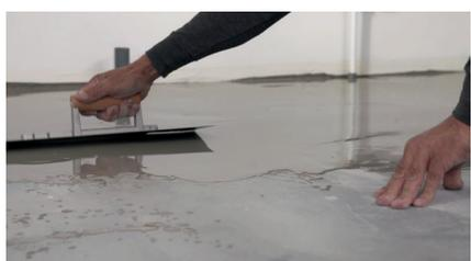
Versez le mélange suivant sur le sol et étalez-le sur une nouvelle zone de 1 à 2 m<sup>2</sup>. en couvrant partiellement la précédente zone.
