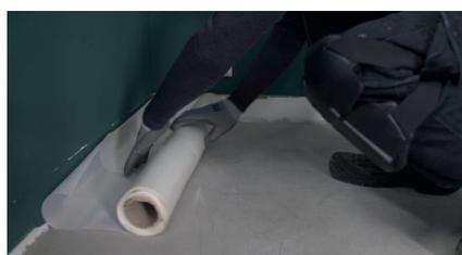
Il est parfois nécessaire de poser un film pare-vapeur sous le stratifié pour le protéger de l'humidité.
