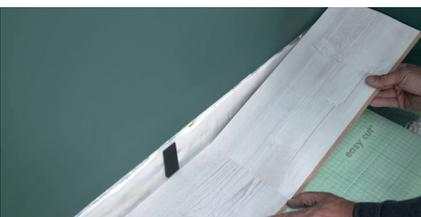
Clipsez la lame coupée en bout de ligne. Posez des cales de dilatation sur la longueur et la largeur de la lame.
