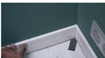
Encollez les plinthes avec de la colle à bois. Posez-les sur les murs en glissant des cales de dilatation entre la plinthe et le stratifié pour assurer la bonne dilatation du bois.
