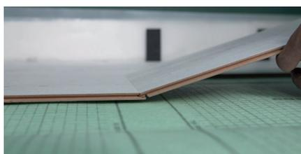
Pour poser la seconde lame, inclinez-la de manière à la clipser d'abord dans la largeur de la lame précédente, puis dans la longueur de la lame de la première ligne.
