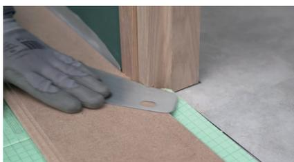
Pour une finition parfaite de votre stratifié, vous devez pouvoir glisser une lame sous les bâtis des portes. Il est donc généralement nécessaire de les scier en partie basse. Pour ce faire, posez une lame de stratifié à l'envers, sur la sous-couche. Sciez le bâti à la scie égoïne, en vous servant de la lame de stratifié comme guide de coupe.
