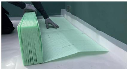
Pour assurer la bonne isolation acoustique et thermique du sol, vous devez ensuite poser une sous-couche sous le stratifié, perpendiculairement au sens de pose des lames.
