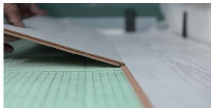
Inclinez-la légèrement pour l'engager dans la languette de la lame de la première ligne.
