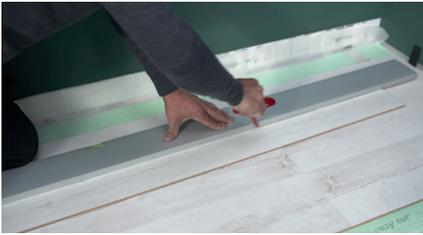
Posez une lame au sol, dans le sens de la pose, et reportez ces mesures sur la lame.
