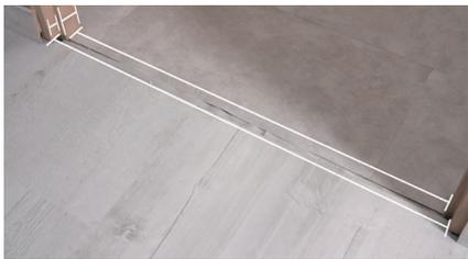
Pour une finition esthétique entre deux revêtements différents, posez une barre de seuil. Mesurez les différentes largeurs du seuil et recoupez votre barre de seuil en conséquence.
