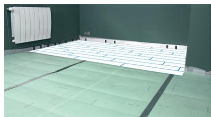
Continuez la pose des lames de la même manière en veillant à alterner les jonctions de lames d'une ligne à l'autre.
