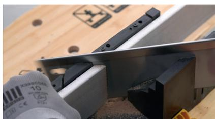
Mesurez la longueur des plinthes à poser. Coupez-les aux mesures à la scie à dos. Pour réaliser les découpes d'angle, utilisez une boîte à onglet.
