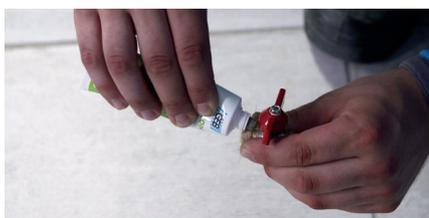
Prenez un morceau de filasse et enroulez-le dans le sens des aiguilles d'une montre sur le filetage du raccord. Appliquez ensuite de la pâte à joint sur la filasse autour du raccord.
