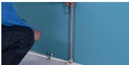
Posez sur le tube coupé, un coude bicône en insérant, comme précédemment, l'écrou libre, puis l'olive et le raccord. Placez le tube dans l'emplacement droit du collier vertical et alignez le raccord sur l'emplacement bas des colliers horizontaux.
