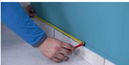
A l'aide d'une règle de maçon, tracez l'axe du cheminement des tubes.
