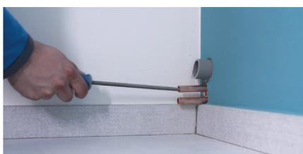
Ebavurez l'intérieur des tubes coupés. Dans notre cas, nous manquons de place. Ainsi, pour accéder plus facilement à l'intérieur des tubes, nous utilisons une lime queue de rat. Poncez ensuite l'extérieur des tubes au papier de verre grain très fin.
