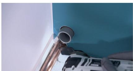
Dévissez l'écrou libre de la platine murale du robinet de machine à la clé à molette, puis dévissez l'ensemble platine/robinet ainsi que la patte à vis.
