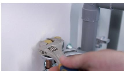
Placez une bassine sous les tuyaux et à l'aide d'une clé à molette et d'une pince multiprise, dévissez les bouchons pour vider les tuyaux de l'installation à déplacer.
