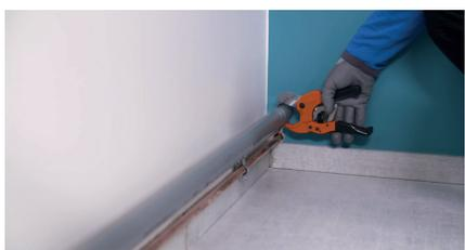
Dans notre cas, pour accéder plus facilement aux tuyaux d'arrivée d'eau, nous allons couper le tuyau d'évacuation à l'aide de la pince coupe-tube PVC et enlever l'ensemble des conduits d'évacuation.
