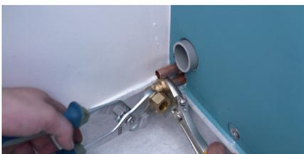
A la sortie des tuyaux d'arrivées d'eau, posez le premier coude bicône en commençant par passer l'écrou libre sur le tube puis l'olive et le raccord. Assurez-vous que les 3 éléments sont bien alignés pour garantir l'étanchéité.
