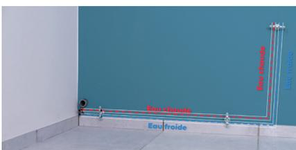
Par convention pour les conduites verticales, le tuyau d'eau froide se situe à droite et celui de l'eau chaude à gauche. Pour les conduites horizontales, l'eau froide se situe en bas et l'eau chaude en haut.
