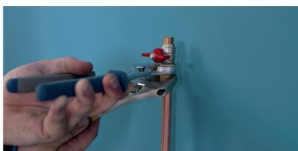
A la main, serrez la vanne sur un raccord bicône et serrez ensuite avec une clé à molette et une pince multiprise.
