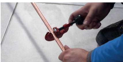
Dans notre cas, la hauteur définie des arrivées d'eau est à 70 cm. Mesurez une hauteur de tube correspondante et coupez à l'aide du coupe-tube. Puis ébavurez les 2 extrémités du tube.
