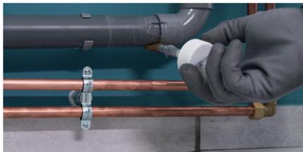
Pour vérifier l'étanchéité du nouveau réseau, versez de l'eau froide dans le tuyau d'évacuation.
