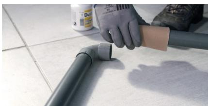
Déclipsez l'installation d'un seul bloc depuis le raccord situé à la sortie de l'évacuation et démontez un premier raccord. Puis, pour un bon encollage, poncez l'extrémité extérieure des tubes ainsi que l'intérieur du raccord.
