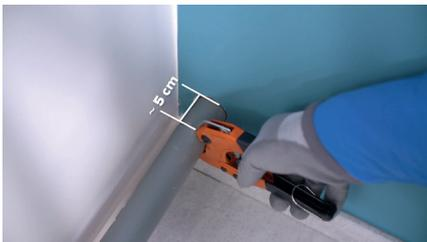
A l'aide du coupe-tube PVC, coupez le tuyau d'évacuation à environ 5 cm du mur.
