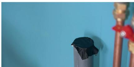
Si votre installation n'est pas utilisée de suite et afin d'éviter les remontées d'odeurs désagréables, placez un ruban adhésif sur l'extrémité du tube.
