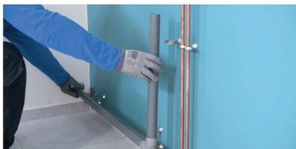
Pour raccorder le nouveau réseau à la sortie de l'évacuation, poncez l'extrémité du tube à la sortie murale, puis réalisez l'assemblage comme précédemment. Clipsez l'installation aux colliers de fixation.
