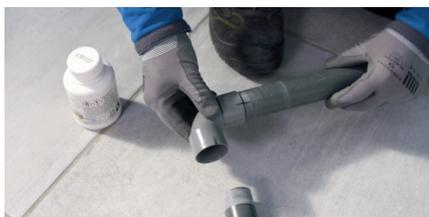
Encollez ensuite l'extrémité des tubes et l'intérieur du raccord. Assemblez-les en respectant les repères tracés. Pour assurer l'étanchéité du réseau, ne tournez pas les parties assemblées. Retirez l'excédent de colle avec le pinceau. Réalisez l'assemblage du réseau progressivement de la même manière.
