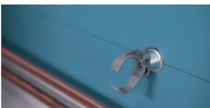
Insérez ensuite les chevilles et les pattes à vis adaptées à la nature de votre mur. Placez des rosaces sur les pattes à vis et vissez les colliers de fixation aux chevilles.
