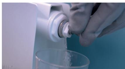
Laissez l'air s'échapper du radiateur jusqu'à ce qu'un jet d'eau régulier s'écoule, sans bruit d'air. Revissez ensuite le robinet de purge à l'aide de votre clé de purge ou votre tournevis plat en tournant dans le sens des aiguilles d'une montre.
