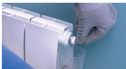
Ouvrez le robinet thermostatique du radiateur à purger en position maximum.
