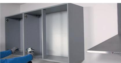
Avant de démonter les caissons hauts, retirez les réglettes lumineuses si besoin. Enlevez ensuite l'ensemble des vis de liaison des caissons hauts. Puis, à l'intérieur des caissons, dévissez légèrement les vis des pattes de fixation.
