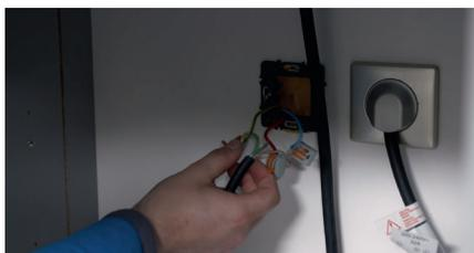
Ôtez ensuite la plaque de finition et la sortie de câble. Dévissez la patte de maintien de câble.
