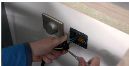
Pour la débrancher, ôtez la plaque de finition et la sortie de câble, dévissez la patte de maintien de câble. Après avoir vérifié l'absence de courant à l'aide d'un tournevis testeur, retirez les fils électriques en desserrant les vis des dominos, puis remettez la sortie de câble.
