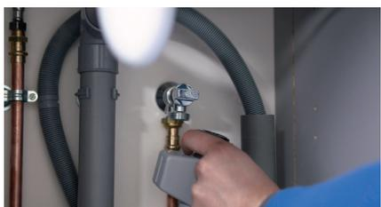
Débranchez ensuite la prise murale. Puis fermez le robinet d'arrivée d'eau et dévissez l'arrivée d'eau. Sortez le tuyau d'évacuation du siphon de machine.
