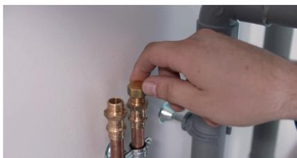
Placez un joint dans chaque bouchon et vissez-les aux arrivées d'eau. Serrez ensuite les bouchons à la clé à molette et à la pince multiprise.
