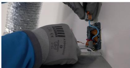
Pour débrancher la hotte, ôtez la plaque de finition et la sortie de câble. Dévissez ensuite la patte de maintien de câble. Après avoir vérifié l'absence de courant, déconnectez les fils électriques des bornes automatiques. Remettez la sortie de câble.
