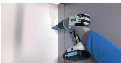
Retirez les caissons et dévissez leurs pattes de fixation murales. Dévissez ensuite les équerres maintenant la colonne au mur et retirez-la.
