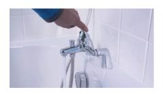
Enfin purgez l'eau des réseaux d'eau chaude et froide. Ouvrez le mitigeur de la baignoire en position tiède ou les robinets d'eau chaude et froide si la baignoire est équipée d'un mélangeur.
