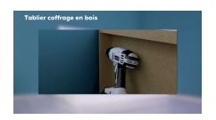
Si vous avez un tablier de baignoire composé d'un coffrage en bois, recouvert ou non de carrelage, dévissez le raccordement d'évacuation de la baignoire pour l'enlever.
