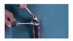
Fermez les arrivées d'eau à l'aide de bouchons. Pour cela, placez un joint dans chaque bouchon puis vissez et serrez sur chaque arrivée d'eau.
