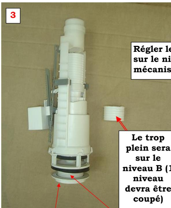
**Régler le clip plastique sur le niveau 4 du mécanisme**
