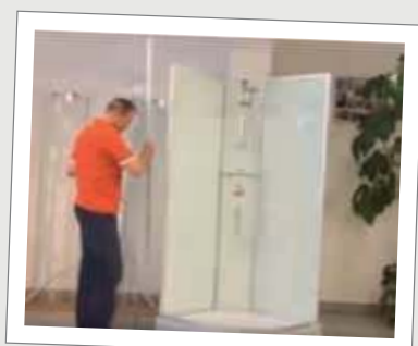
puis j'emboîte les panneaux arrières et la robinetterie...
