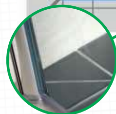
La paroi tombe mi-verre sur le joint du repose à carrelage.
