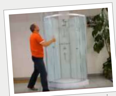
et pour finir, je monte les parois.
