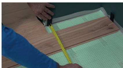
Ensuite, prenez les mesures de la lame à couper. Pour cela, placez une cale de dilatation contre le mur et mesurez la largeur, de la cale à la lame, en 2 endroits. Puis repérez la longueur de la future lame.
