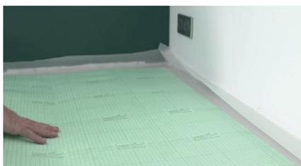
Afin d'apporter une isolation thermique et phonique au sol, il est nécessaire de poser une sous-couche avant de poser le parquet. Pour cela, posez la sous-couche au ras des murs, perpendiculairement au sens de pose des lames de parquet. Coupez-la au cutter.
