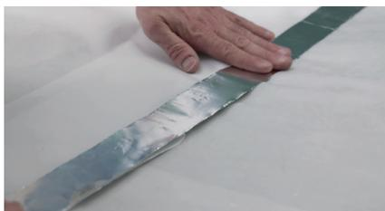
Posez les bandes de film pare-vapeur en prenant soin de bien les faire remonter sur les bords des murs. Coupez les bandes au cutter et faites-les se chevaucher pour empêcher l'humidité de remonter. Collez les bandes entre elles à l'aide de ruban adhésif aluminium étanche.
