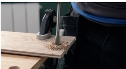
Pour effectuer la découpe de la lame, commencez par la percer à la perceuse équipée d'une mèche à bois plate.
