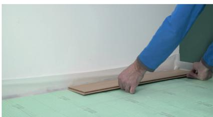
Posez une première lame de parquet dans un angle de la pièce. Les rainures de la lame doivent être placées vers le mur. Ainsi, ses languettes permettant de clipser la deuxième rangée de lames seront placées du bon côté.
