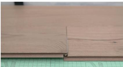
Pour poser la seconde lame, inclinez-la de manière à la clipser d'abord dans la longueur de la lame de la première ligne, puis dans la largeur de la lame précédente.
