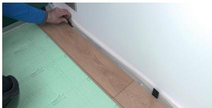
Enlevez la cale de dilatation posée en bout de mur et clipsez la lame sur la précédente.
