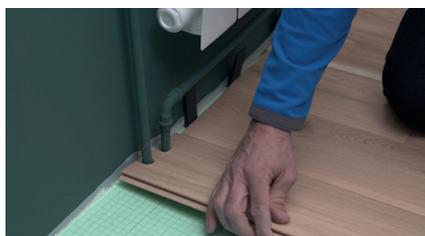
Clipsez la lame et posez une cale de dilatation entre le mur et la lame découpée.
