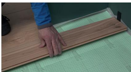
Pour poser le parquet autour d'un angle sortant, prenez les mesures de la lame qui le bordera. Pour cela, clipsez une lame repère dans l'alignement de la dernière rangée posée. Insérez une cale de dilatation contre le mur. Puis clipsez une seconde lame repère contre la précédente, en la calant contre le mur. Posez une cale de dilatation en bout de mur.
