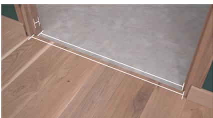
Pour une finition esthétique entre deux revêtements différents, posez une barre de seuil. Mesurez les différentes largeurs du seuil et recoupez votre barre de seuil.
