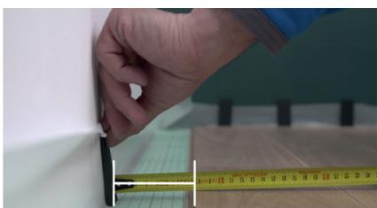
Pour poser la dernière rangée de lames, il est souvent nécessaire de couper les lames dans leur longueur. Pour mesurer la largeur des lames à poser, placez tout d'abord une cale de dilatation contre le mur. Mesurez ensuite la distance entre la dernière rangée de lames et la cale de dilatation, à 2 endroits différents.
