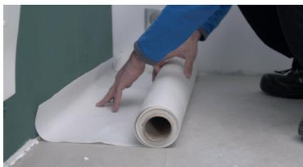
Il est parfois nécessaire de poser un film pare-vapeur sous le parquet pour le protéger de l'humidité.
